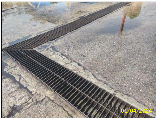
ระบบรวบรวมน้ำบริเวณพื้นที่ขนถ่ายถ่านหินเข้าสู่บ่อตกตะกอน
