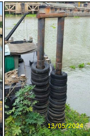
ติดตั้งหลักผูกเรือ และยกกันกระแทกเรือบริเวณท่าเรือ
