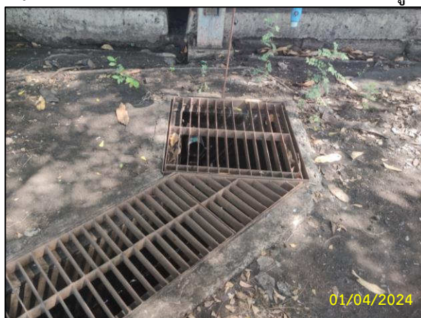
ค) ระบบระบายน้ำและบ่อหน่วงน้ำด้วยท่อระบายน้ำบ่อกักน้ำ คสล. (Manhole)
